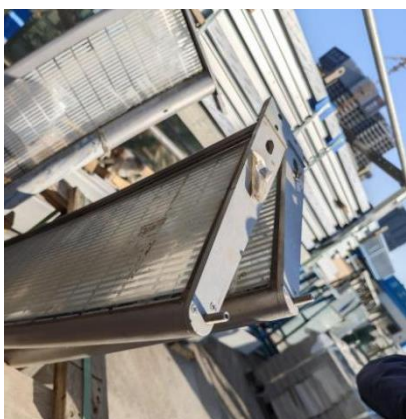
图 12 飘板（样板）檐口情况
